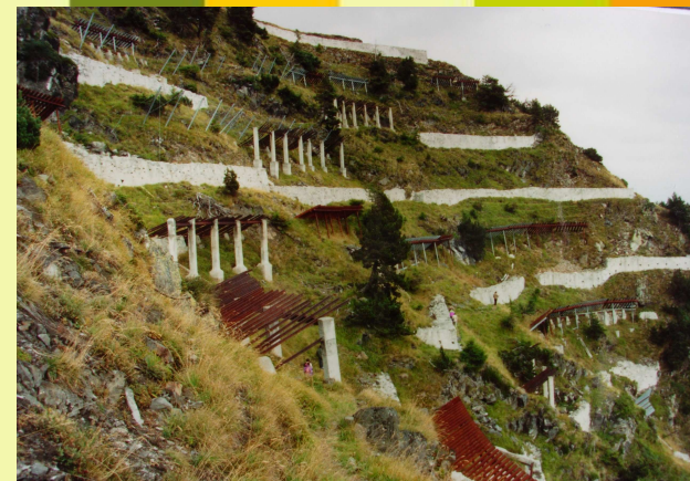
Piliers béton, murs béton et râteliers
